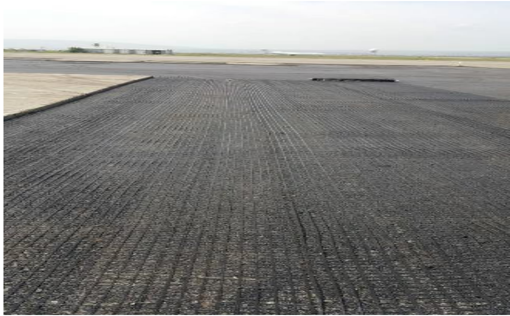
ნახ. 23. აეროპორტებში ასფალტბეტონის საფარის მშენებლობის მინერალური ბოჭკოების ბაზაზე დამზადებული ბადე-ქსოვილებით
