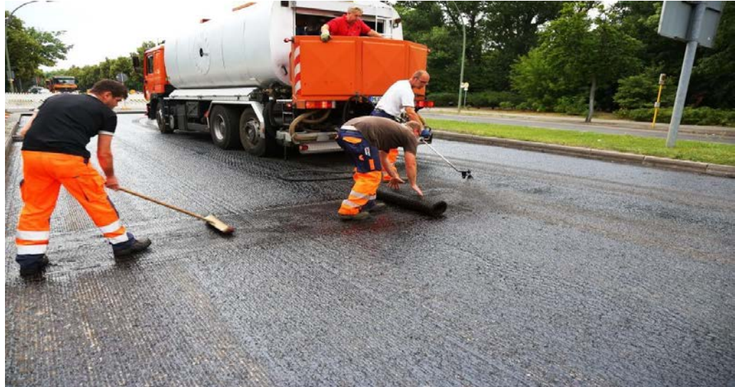
ნახ. 21. შპს „ბაზალტ ფაიბერსის“ ის წარმოების მინერალური ბოჭკოების ბაზაზე დამზადებული ბადე-ქსოვილების ტესტირება
